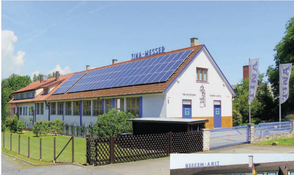
Unser Produktionsgebäude in Reutlingen von Süden
